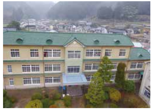
ヤマモトロックマシン(旧山本鉄工所) 自治察家族棟 (東城 / F-3)
