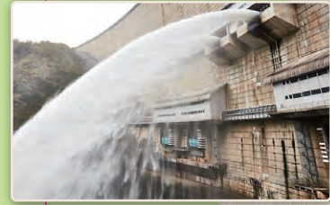
温井ダム 日本ダム湖百選 日本第2位のアーチ式ダム 高さ156m、長さ385m (P9)
